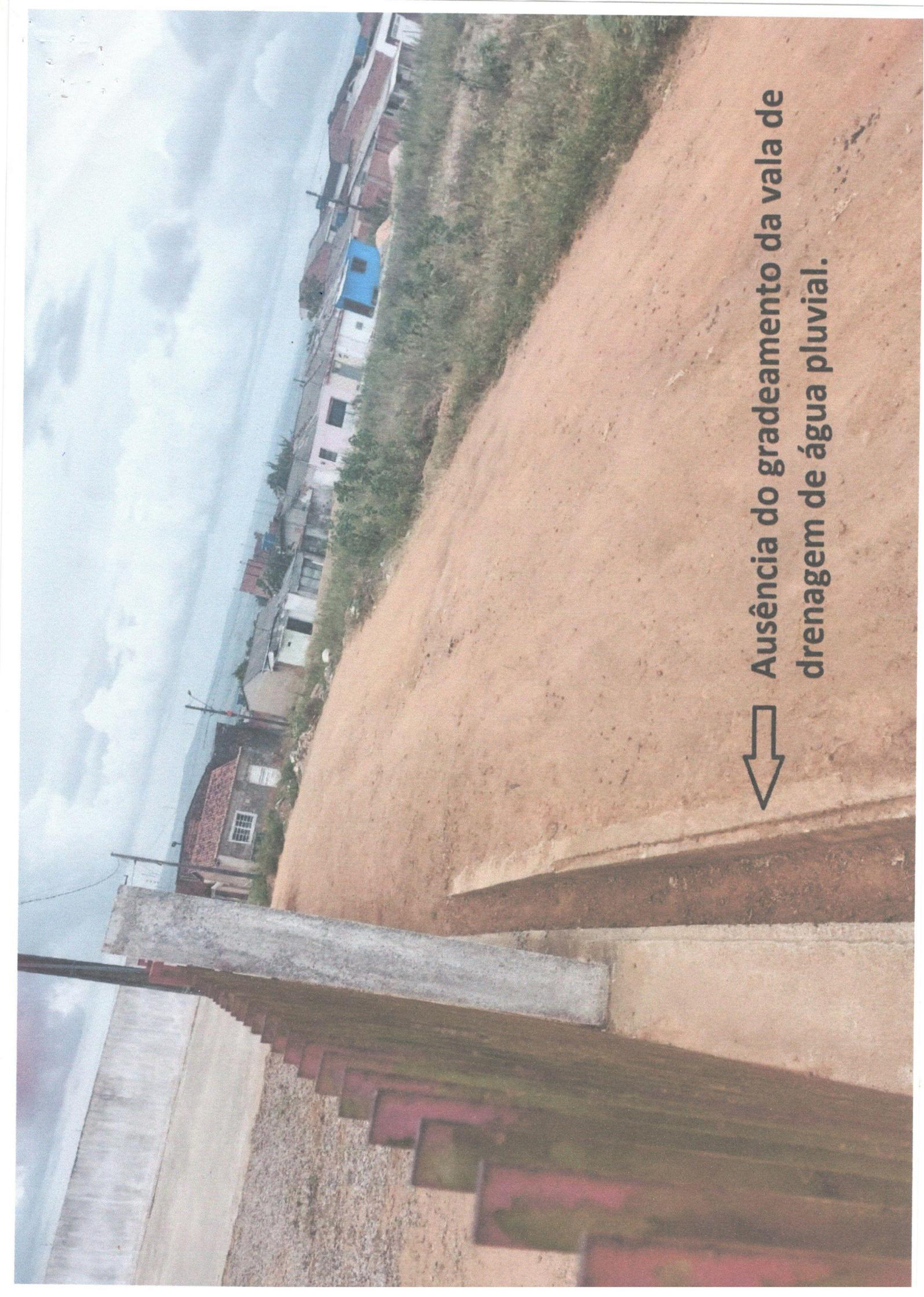
→ Ausência do gradeamento da vala de drenagem de água pluvial.
