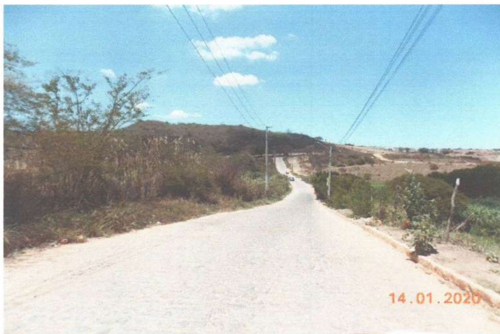
FOTO 12 – Rua José Armando Machado atualmente sendo o acesso principal para a área do empreendimento. FONTE: Aluisio Sales, 2020.
