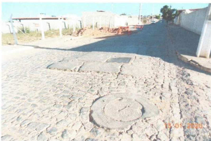
FOTO 23 – Sistema de esgotamento sanitário existente no Loteamento São Vicente. FONTE: Aluisio Sales, 2020.
