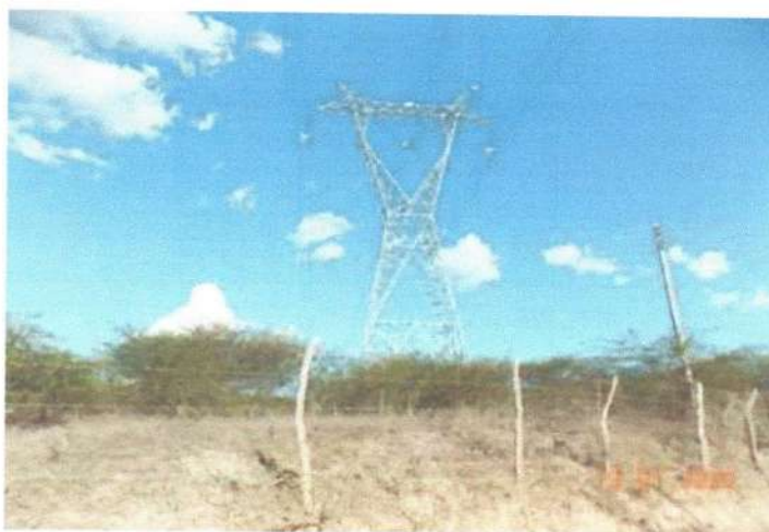
Figura 4 – Linha de Transmissão de 230 kV da CHESF na área do terreno onde será implantado o empreendimento.
