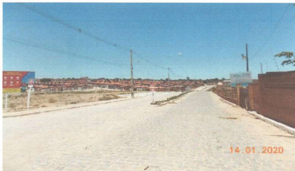
FOTO 13 – Via principal de acesso Bairro Dom Hélder Câmara (Loteamento São Vicente). FONTE: Aluício Sales, 2020.
