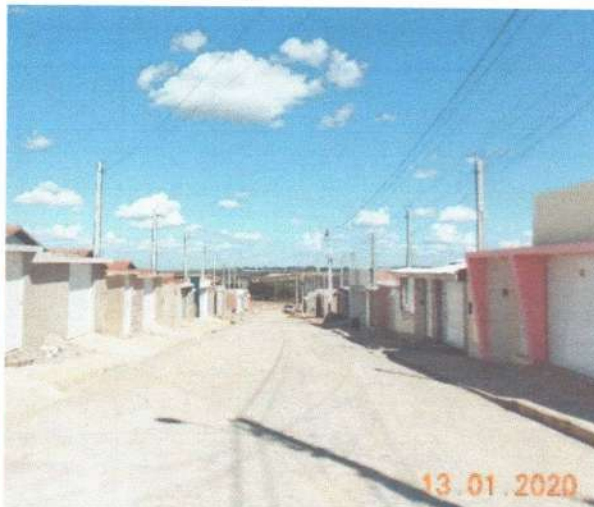
FOTO 47 – Visão geral do padrão construtivo no Residencial Antônio Cordeiro.
