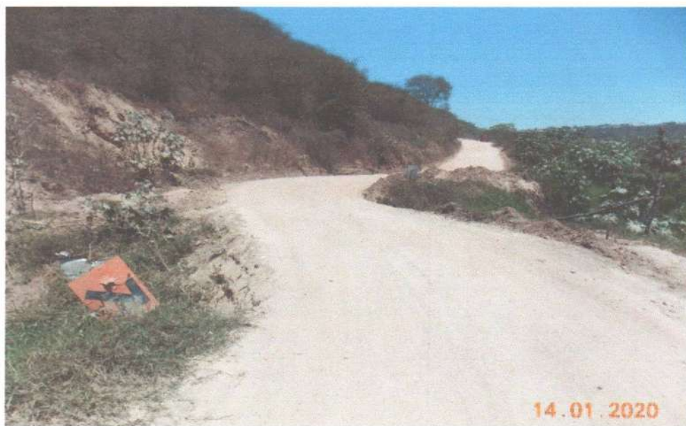
FOTO 9 – Trecho da Estrada de São Pedro que corta o Rio São Vicente com estreitamento impedindo a passagem de veículos de grande porte. FONTE: Aluisio Sales, 2020.
