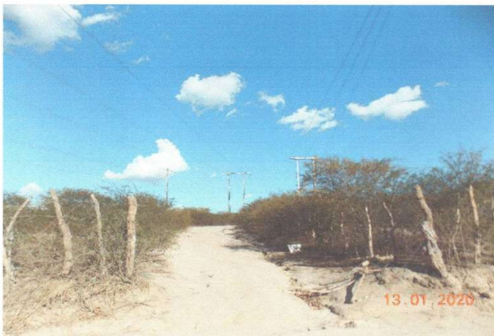
FOTO 6 – Linhas de Distribuição de 69 kV DA CELPE na área do terreno onde será implantado o empreendimento. FONTE: Alúcio Sales, 2020.
